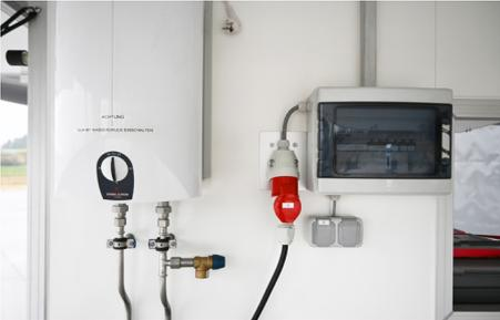
5 l Warmwasserboiler und Verteilerkasten mit 400 V-Steckdose und 230 V-Doppelsteckdose
