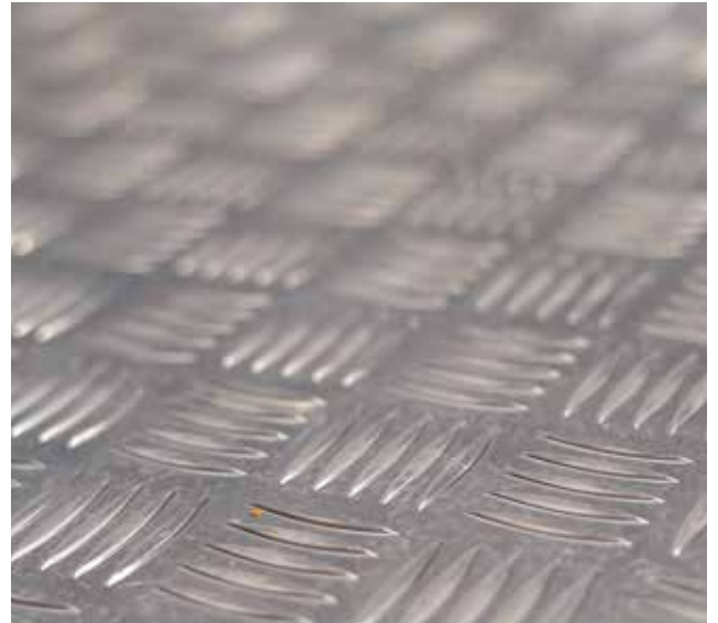
Boden mit Alu-Riffelblech belegt
